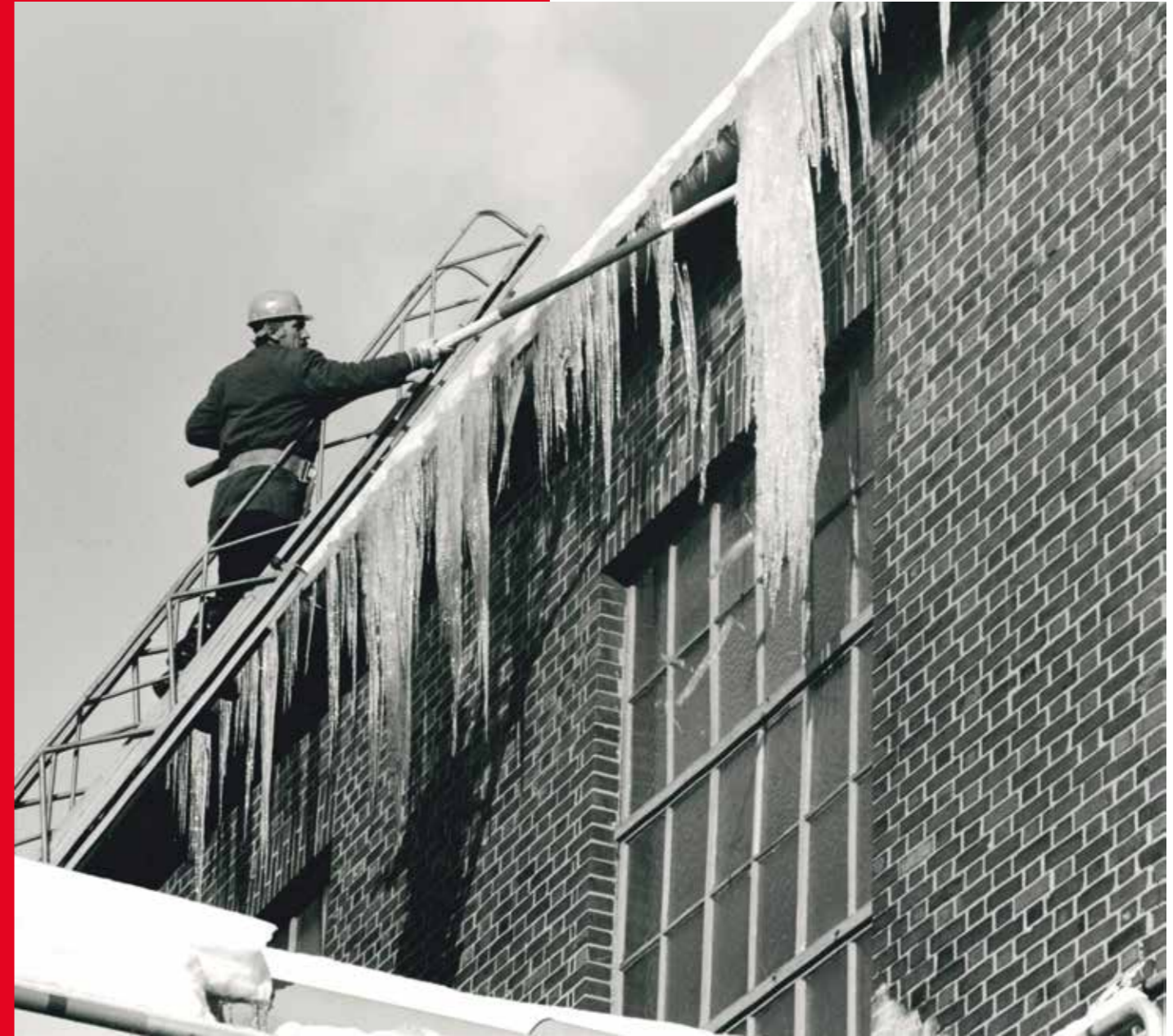
Sondereinsatz: Im kalten Winter 1982 mussten durch die Werkfeuerwehr Eiszapfen am Kesselhaus entfernt werden.
