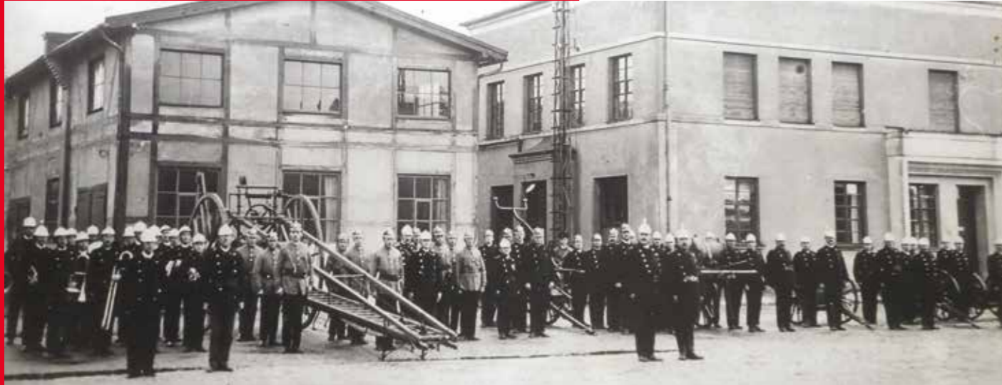
Die freiwillige Fabrikfeuerwehr war bei der Gründung mit Handkarren, Handdruckspritze, Schlauchkarren und einer Auszugsleiter ausgestattet. (Foto von 1920)
