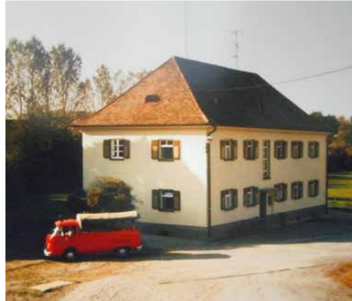
Einrichtung der Feuerwache im ehemaligen Wohnhaus Liebigstraße 76
