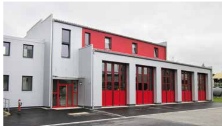
Neubau der Feuerwache mit Fahrzeughalle
